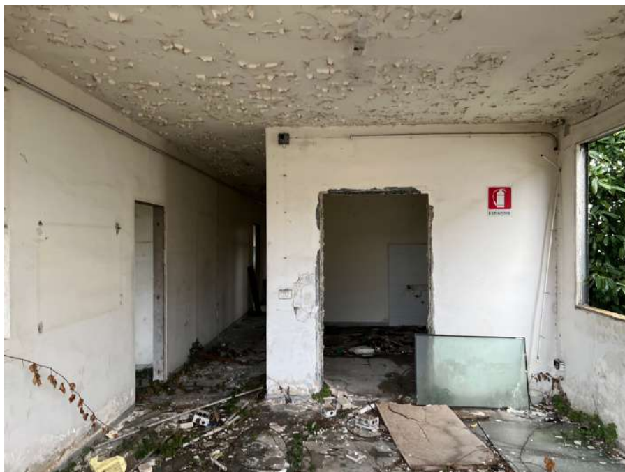
GUARDIANIA E PALAZZINA DEI SERVIZI (INTERNI)
