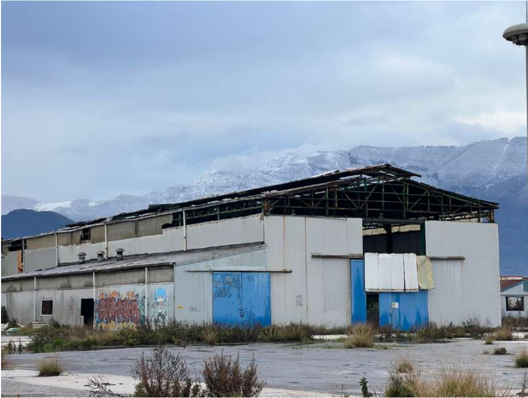
CAPANNONE PRODUTTIVO (ESTERNO)
