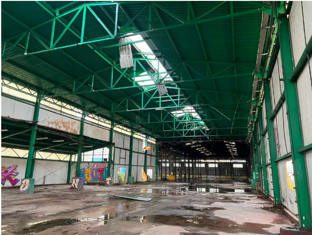
CAPANNONE PRODUTTIVO (INTERNO)
