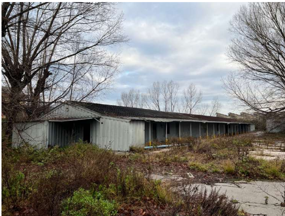
LOCALE DEPOSITO E LAVORAZIONI ACCESSORIE
