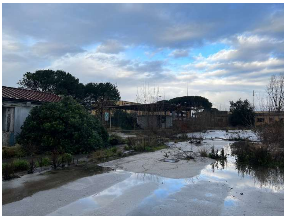
TETTOIE E PICCOLO DEPOSITO
