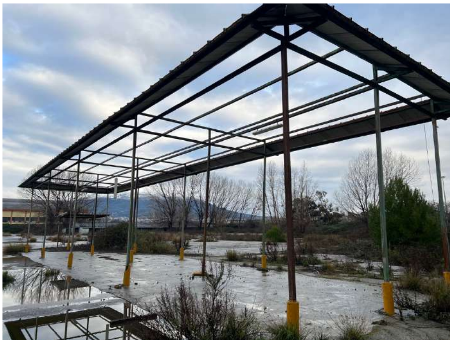
TETTOIE E PENSILINE
